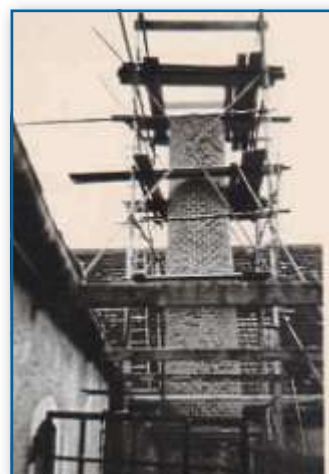
Der Bau des Turmes für die Dampfanlage. Repro: Frühmorgen
