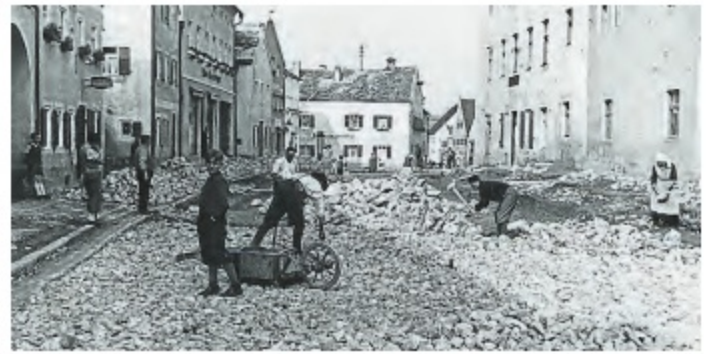
Bis ins letzte Jahrhundert hinein erfolgte der Straßenbau in Kösching in gemeinschaftlicher Handarbeit. Die Photographien aus dem Sommer 1939 lassen die Mühsal der Arbeit erahnen.
