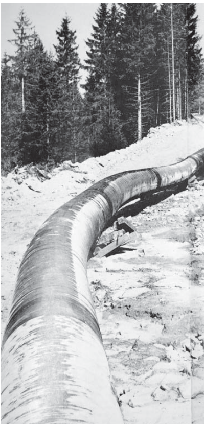
Bauabschnitt der Transalpinen Oelleitung (TAL) durch die Berge
